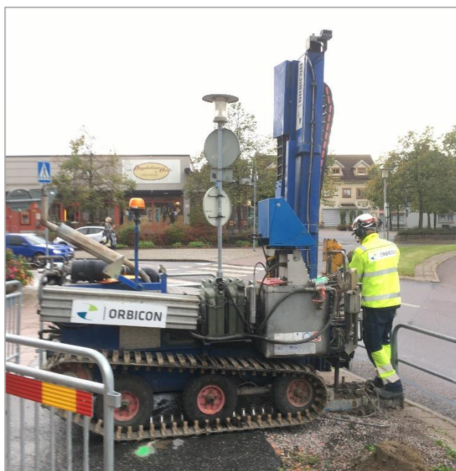
Figur 6. Installation av djupt grundvattenrör i BH/GV1.
