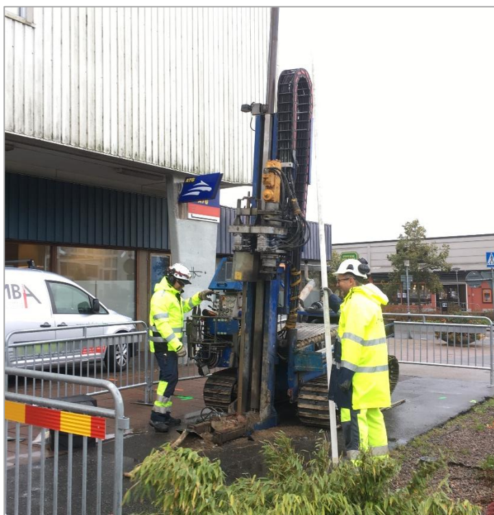
Figur 5. Installation av grunt grundvattenrör i BH/GV4.
