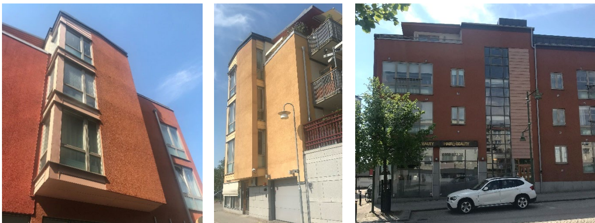
Exempel på hur detaljer i fasaderna kan utföras i annat material än trä eller puts med bibehållen känsla av helhet. Bilderna visar angränsande bebyggelse nordväst om planområdet.
