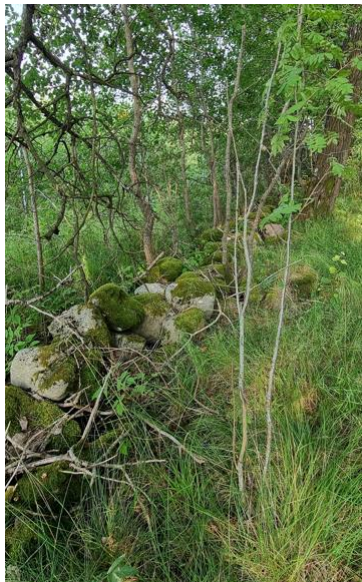
Figur 5 Befintlig stenmur inom detaljplan (Ramboll, 2021-08-17)
