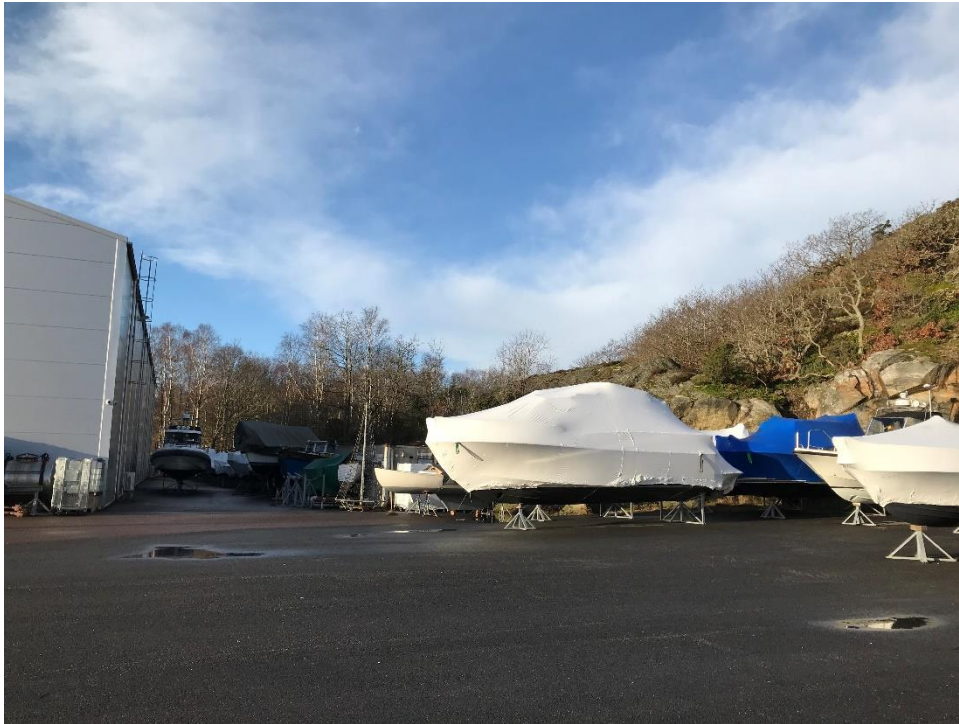
Figur 15. Bergsrygg bakom befintlig båthall. Vy från öster.
