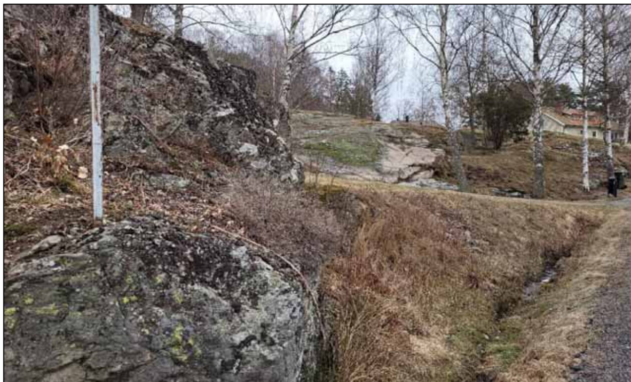
Figur 10-45 – Bergförekomst i Delområde 8. Bergmassan är homogen och har liten grad av uppsprickning.
