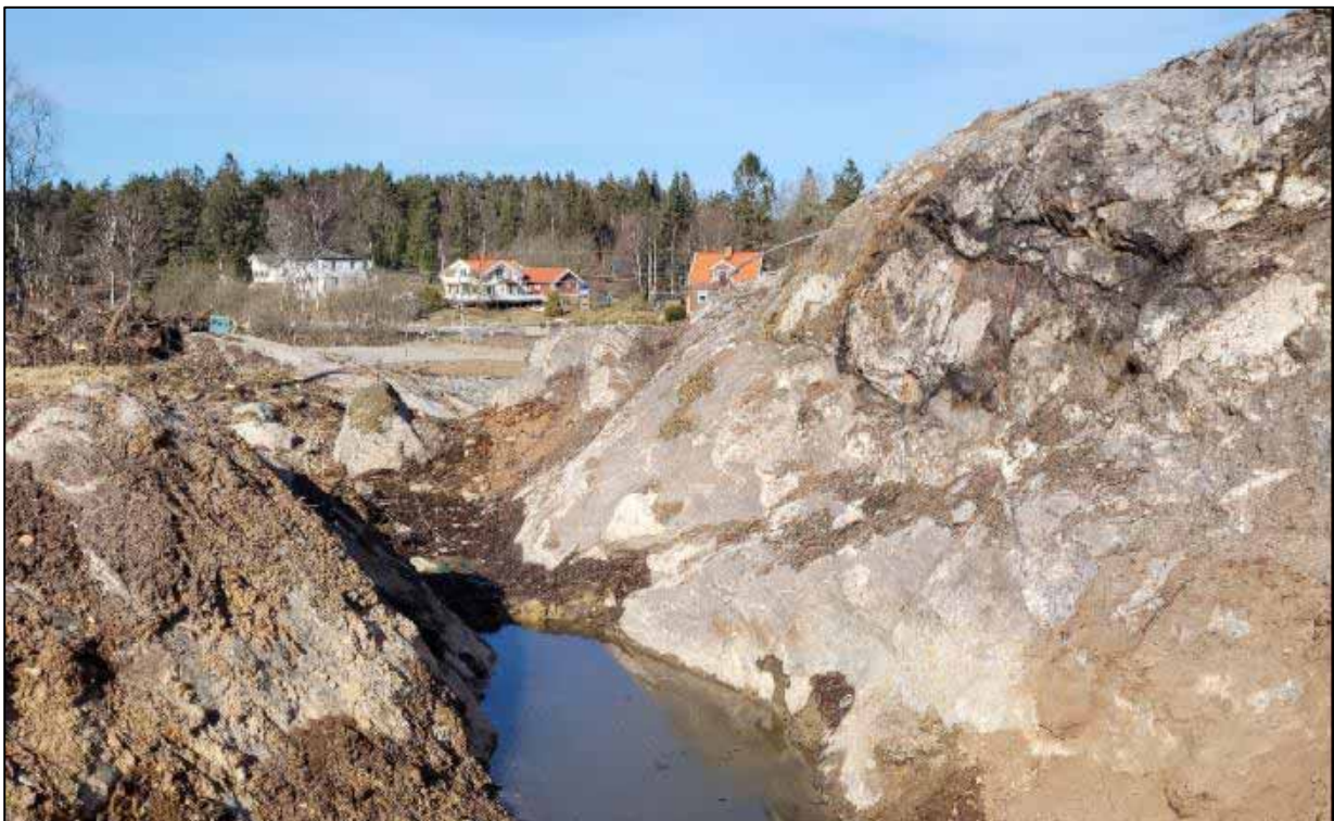
Figur 10-42 – Bergförekomst i södra delen av Delområdet 6. Spägning av berg och schaktarbete pågick i området under platsbesökets tillfälle.
