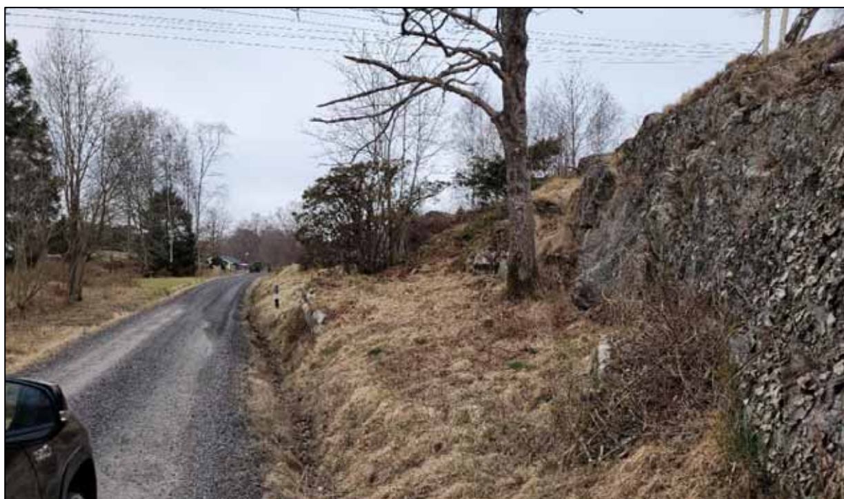
Figur 10-46 – Bergförekomst i Delområde 8. Bergmassan är homogen och har liten grad av uppsprickning.
