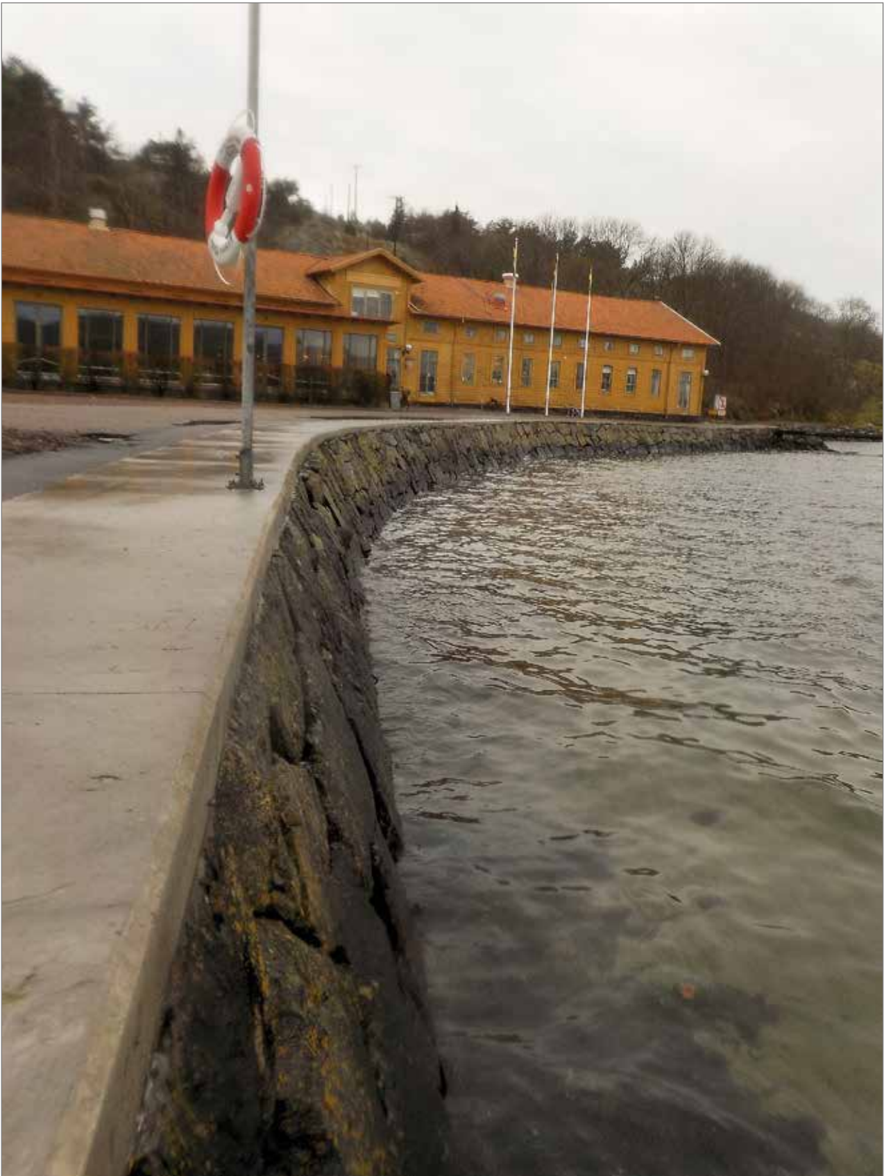
Figur 3. Utredningsområdet ansluter mot Kungsplan och det gamla varmbadhuset, idag vandrarhemmet Bätellet. Foto Thomas Bergstrand, Bohusläns museum.
