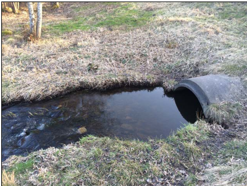
Figur 37. Dagvattentrumma under Alekärrsvägen, MP1b
