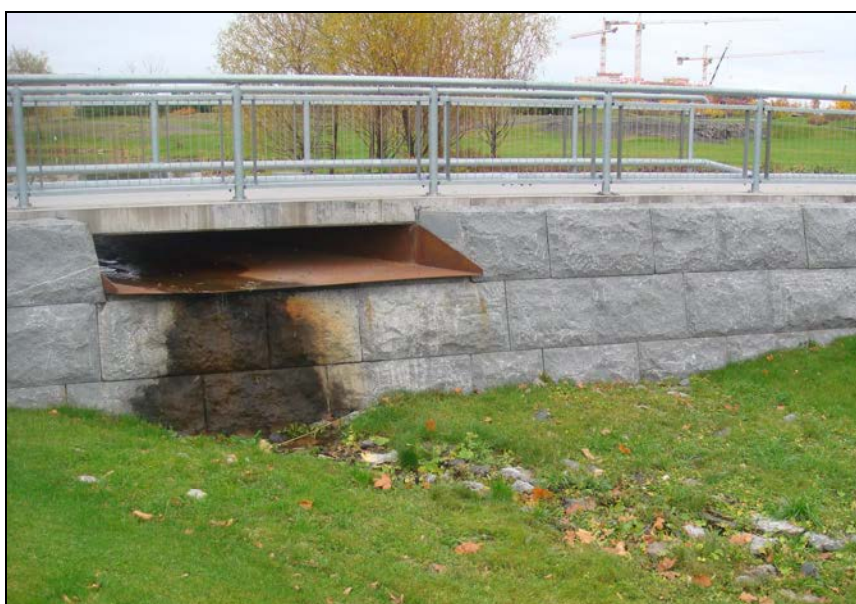
Figur 44. Utlopp genom brokonstruktion i Fornebu, Norge
