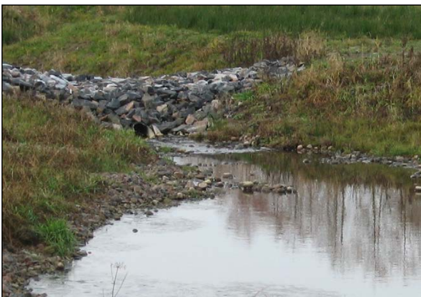
Figur 42. Reglerat utlopp ifrån dagvattendike i Brottkärr, med en mindre utloppsledning i botten på diket och en högre bräddnivå för kraftigare nederbörd
