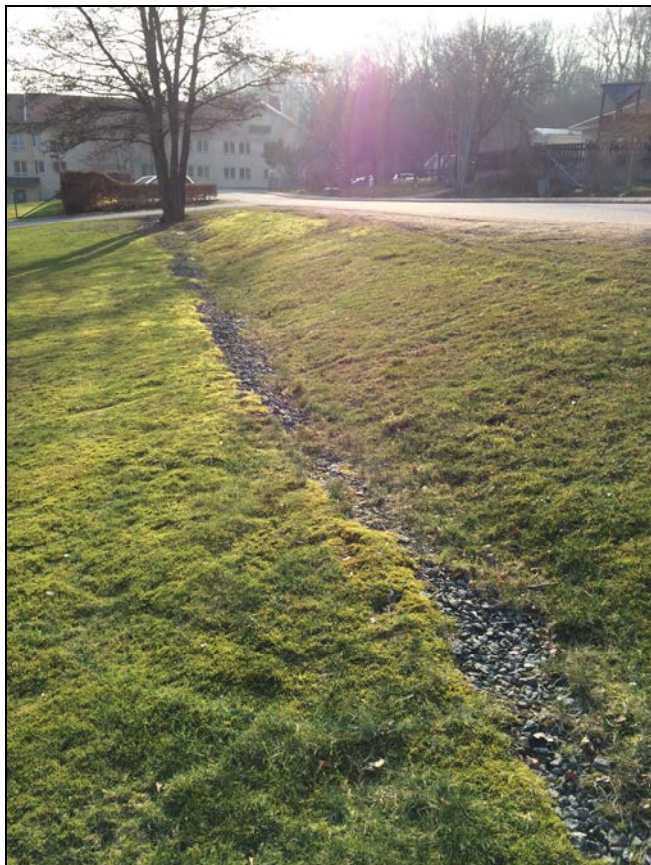
Figur 25. Avskärande dike invid platåer leder dagvatten till ledningssystem i Diserödsvägen
