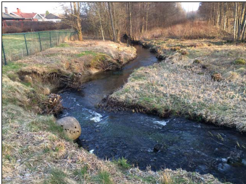
Figur 38. Dagvattentrumma under Olvonvägen, MP1c. Planområdet Tyfter avvattnas via denna trumma mot Välabäcken
