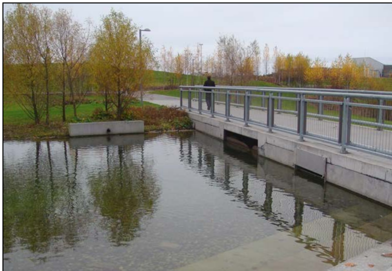
Figur 45. Områdesbild uppströms utlopps lösning genom brokonstruktion i Fornebu, Norge
