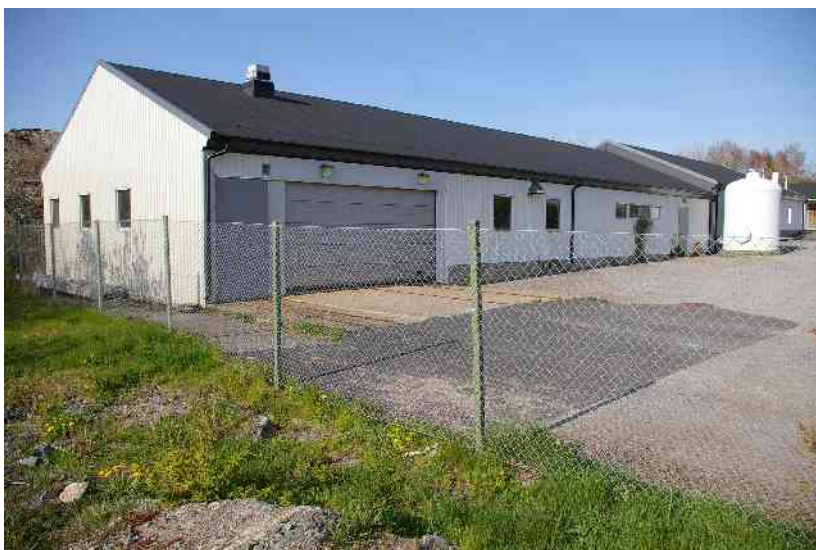
Bild 32. Det befintliga avloppsreningsverket på Koön.
