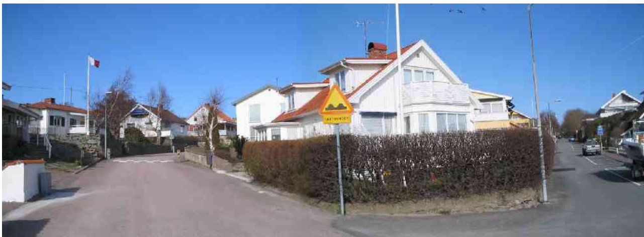
Bild 5. Villakvarter längs Idrottsgatan och Vallhjonsgatan på Koön.
