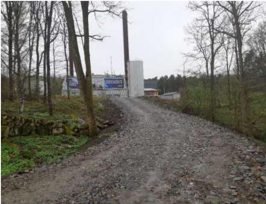
Figur 8. Objekt 2 och 3 avgränsas av en nyanlaggd väg.
