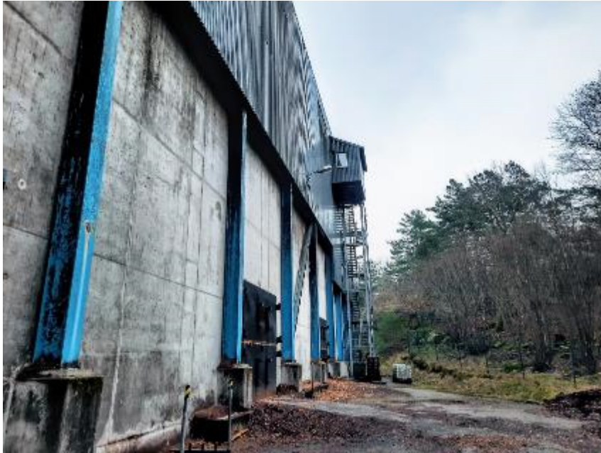
Figur 17. Port på baksidan av lagret igenom vilken glödbanden kunde schaktas ut och släckas.
