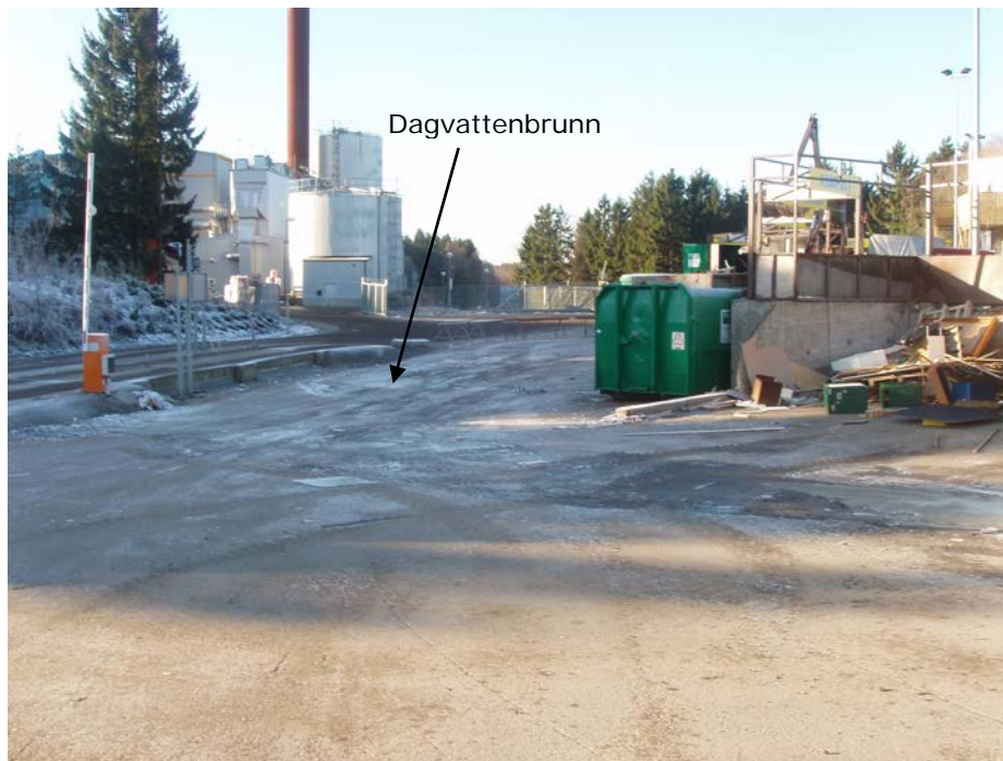
Bild 4 Vy över lågpunkt och dagvattenbrunnen inom området
