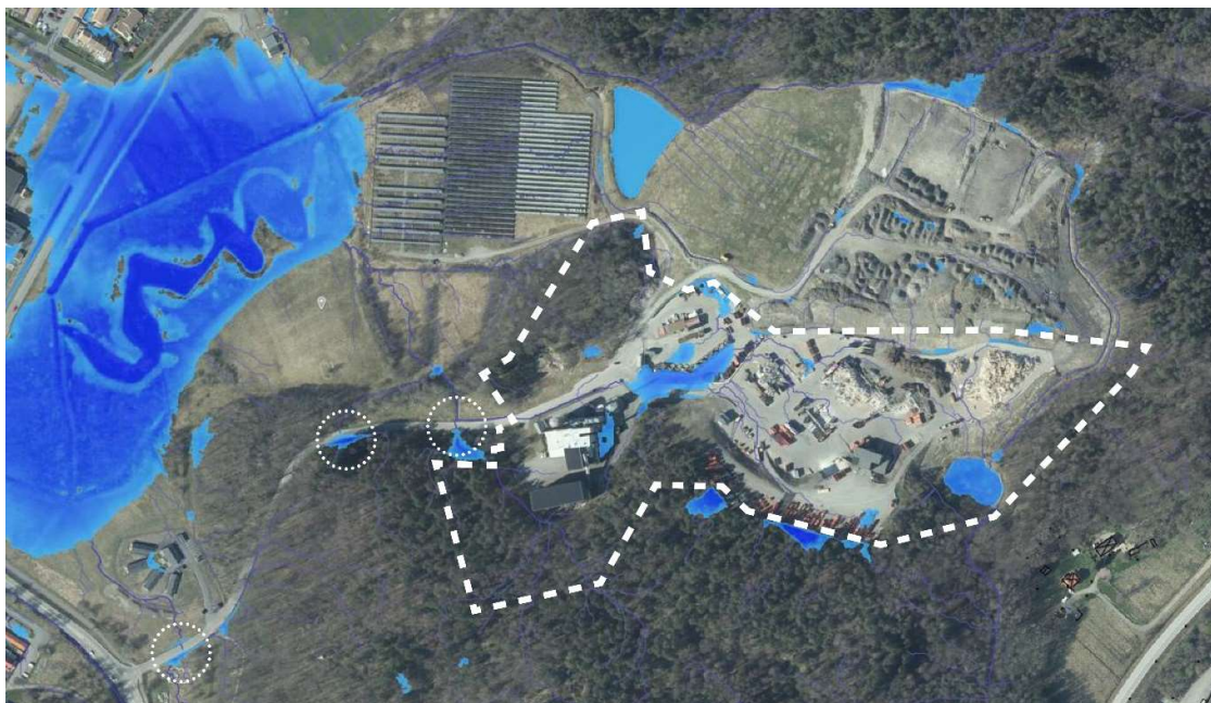
Figur 15. Karta med marköversvämningsytor (blå fält) och rinnvägar (blå linjer) vid ett 100-årsregn för nuläget utan utbyggnad. Planområde är markerat med vit streckad linje. Vita cirklar markerar riskområden vid Energivägen, där översvämning kan få konsekvenser för tillgängligheten till planområdet.
