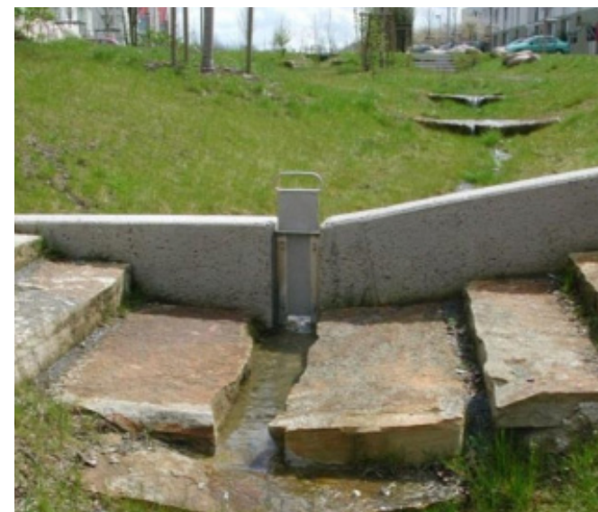
EXEMPEL PÅ DAGVATTENDIKE MED FÖRDRÖJNING. FOTO: NORCONSULT.
