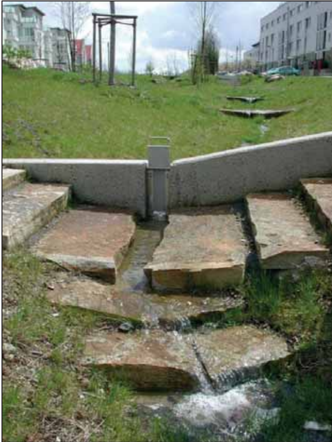
Figur 33. Exempel på dagvattendike med fördröjning i Kronsberg, Tyskland (Foto: Norconsult).
