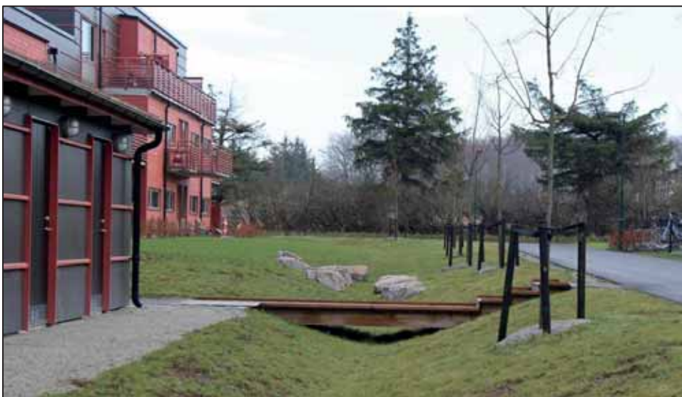
Figur 37. Torr översvämningsyta mellan hus och GC-bana, Gyllins trädgård i Malmö (Foto: Norconsult).
