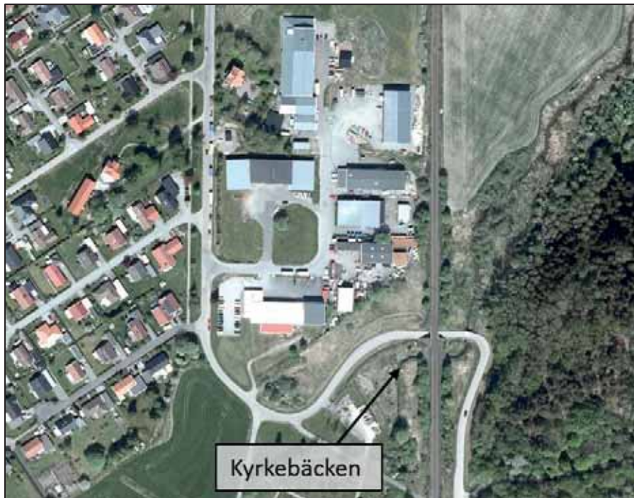
Figur 45. Valnäs industriområde. Utformning med ex. kantstöd föreslås för att säkerställa att släckvattnet stannar inom området i samband med brand där dagvattenbrunnar stängs.
