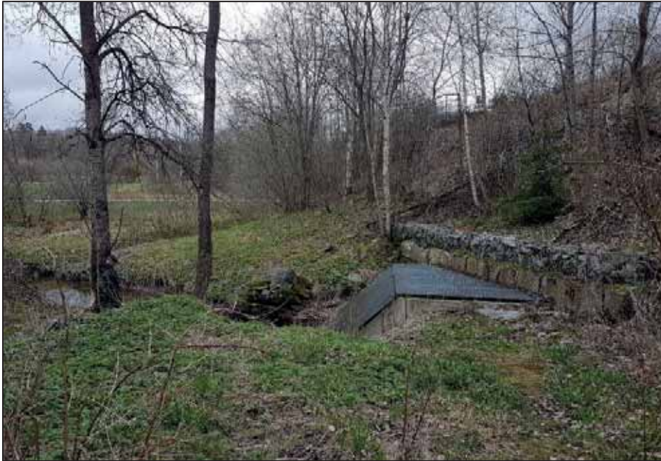
Figur 28. Galler vid kulvert under järnvägen vid Tungevägen (Foto: Norconsult).
