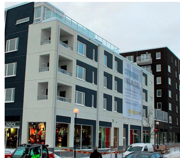
FÖRTÄTNING MED BÅDE LOKALYTA OCH BOYTA I MÖLNLYCKE CENTRUM
