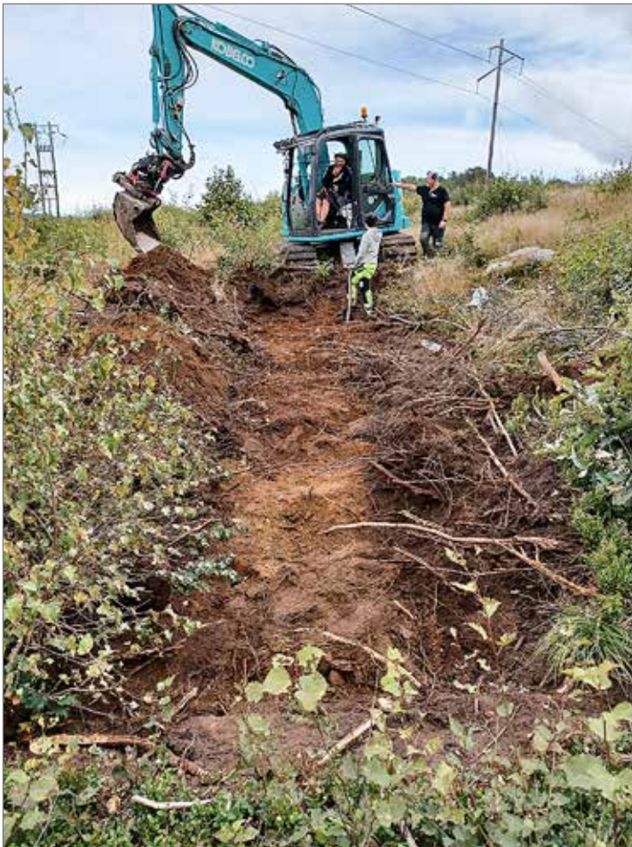
Figur 8. Schaktning i västslänten strax intill L2021:6078. Foto taget från sydväst. Foto av Mattias Frisk, Bohusläns museum.
