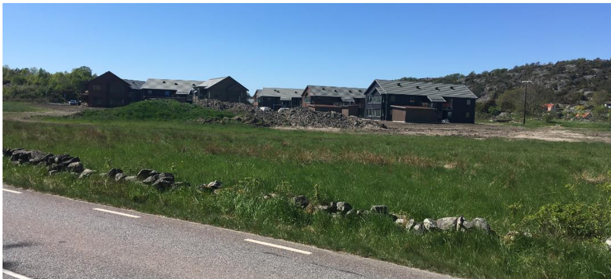
Tjuvkils ängar, ett bebyggelseområde under framväxande. Ytterligare bostadsbebyggelse är under uppförande i området mellan vägen och den nya bebyggelsen.
