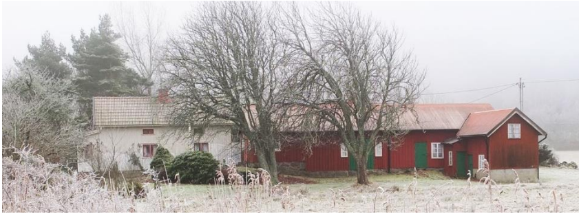
Västra sidan av "entrén" till Tjuvkil. Äldre fastighet med soldattorp som hört till gårdarna Kroken och Nordgården. Vägen går omedelbart till vänster om bilden och bostadshusets gavel vetter mot vägen.
