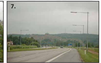
7. Kungälv Från E6 söderifrån - en mäktig vy och stadsentré.
