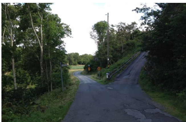
Tjällviksvägen och vägen upp till Instölid, Norra Instön
