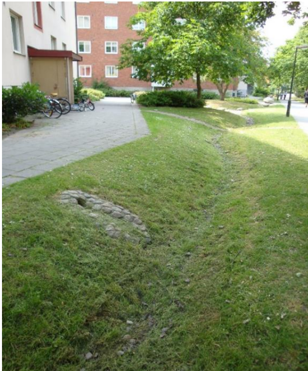
Figur 19. Svackdike med anslutande ledning från stuprör. Foto: Sweco.
