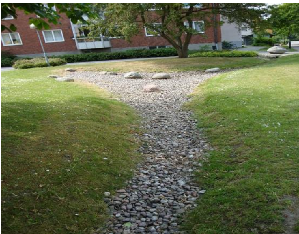
Figur 18. Stenfyllt svackdike/magasin med avgränsande gångvägar. Foto: Sweco.
