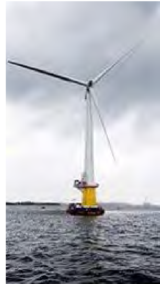
Första Hywindverket på plats. Rotordiametern är 82,4 meter. Turbinen på 2,3 MW väger 138 ton. Foto: Hild Bjelland Vik/Statoilhydro.
