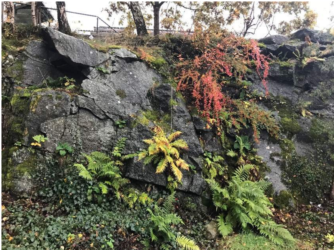
Figur 12. Sprängd bergyta i anslutning till parkeringsyta. Staket på toppen tillhör förskolan.
