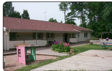
Bild: Ulvegärde förskola
