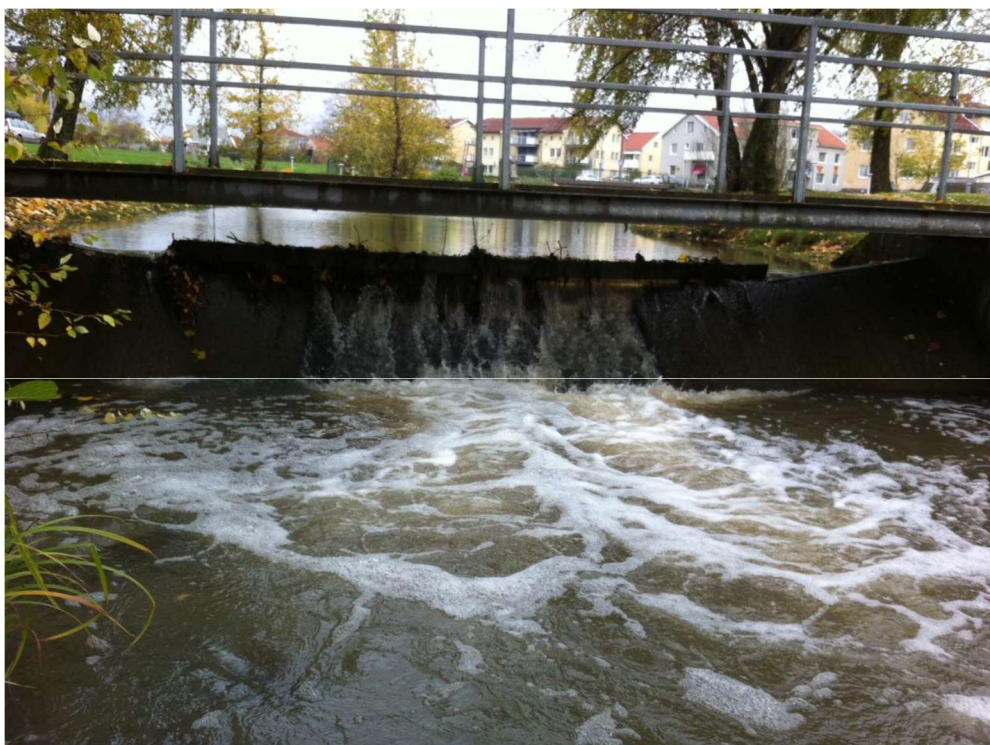
Bild: Dammen i centrala Kungälv. Notera plankorna på toppen av dammkrönet som tidigare hindrade havsöringens vandring.
