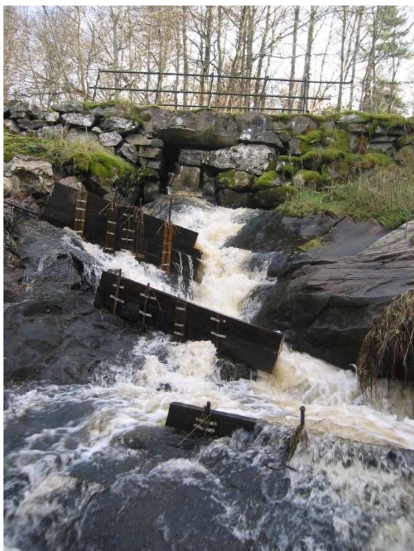
Bild: Fisktrappa byggd vid kvarndammen i Skårby 2006.
