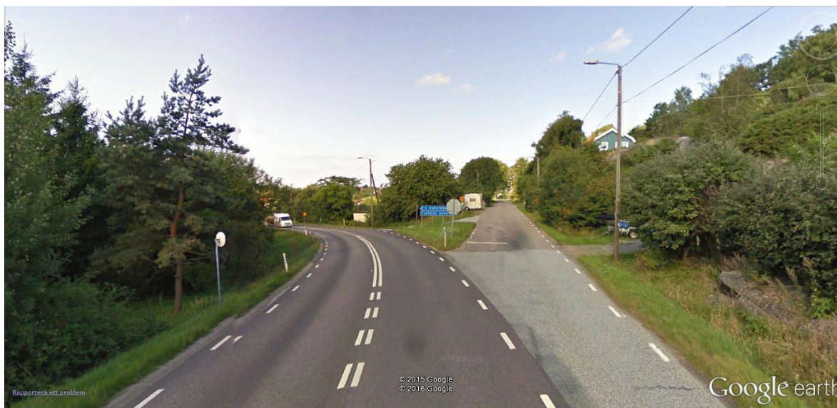
Tjuvkils vägskäl, en mindre trafiksäker anläggning som åtgärdas genom vägplanen. (Källa: Google Earth).
