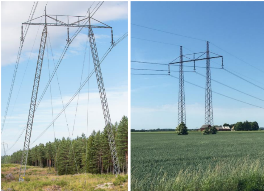
Figur 4. Exempel på stolpar. Stagad A-stolpe (till vänster). Ostagad B-stolpe (till höger).
