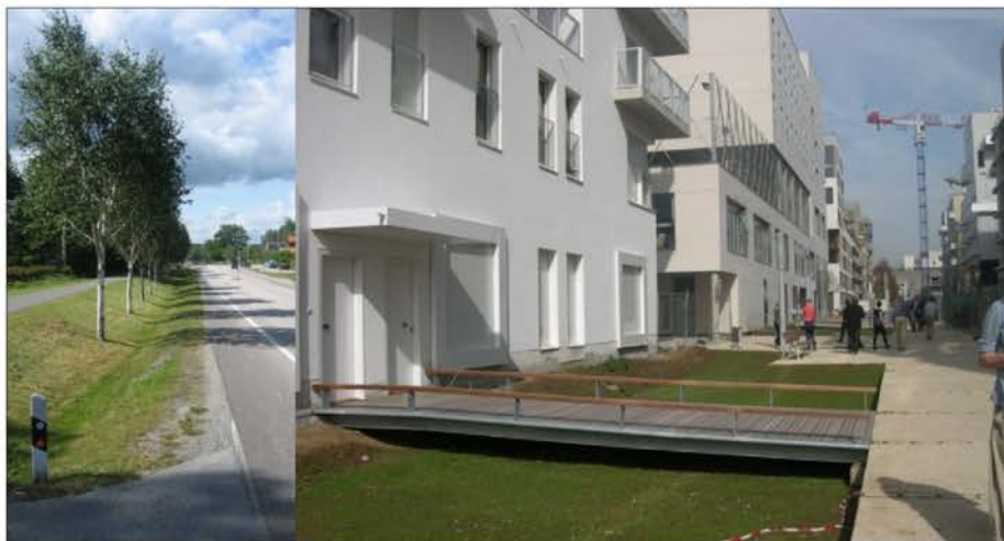
Figur 18. Exempelbilder på svackdiken (Foto: Sweco).
