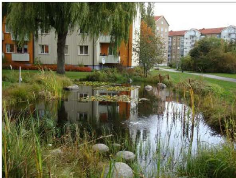
Figur 14. Exempelbild dagvattendamm (Foto: Sweco).
