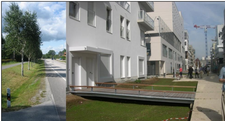
Figur 18. Exempelbilder på svackdiken (Foto: Sweco).
