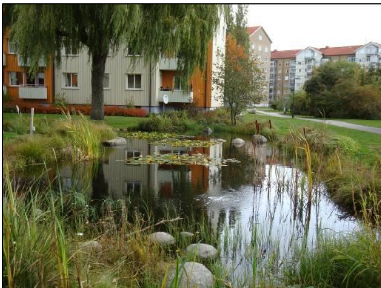
Figur 14. Exempelbild dagvattendamm (Foto: Sweco).
